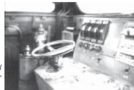
*El puesto de mando de las Alsthom, con el pupitre al centro y la manivela del controller con volante.*
