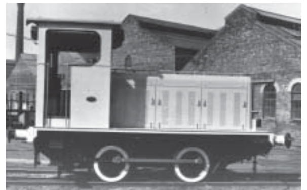
Uno de los 10 locotractores Drewry de los ferrocarriles Sud y Oeste, propulsados también por un Gardner 6LW
