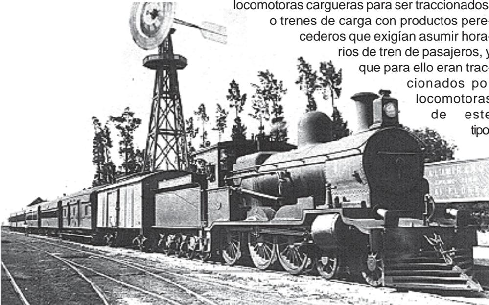
Locomotora de la clase 12 del FCS número 514, juntamente con sus hermanas de la Clase 6 del FCO, P-7a del FCCA y 1400 del FCBAF. Esta familia con sus 220 unidades representa el ejemplo clásico de la locomotora Mixta de la Trocha Ancha.
